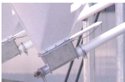
Boîtier de déchargement à sortie simple, muni d'une vanne giratoire pour un vidage complet du silo
